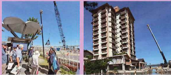
写真左：崩壊した岸壁の復旧工事現場 写真右：激しく損傷した老舗旅館「加賀屋」の解体工事が始まる 「公助」を待つだけでなく、地域住民や事業者が「共助」の精神で立ち上がることの重要性と、観光産業の復興が地域全体の活力を取り戻すために不可欠であること、そして、「正しい現状を発信すること(風評被害の防止)」の大切さを学びました。
